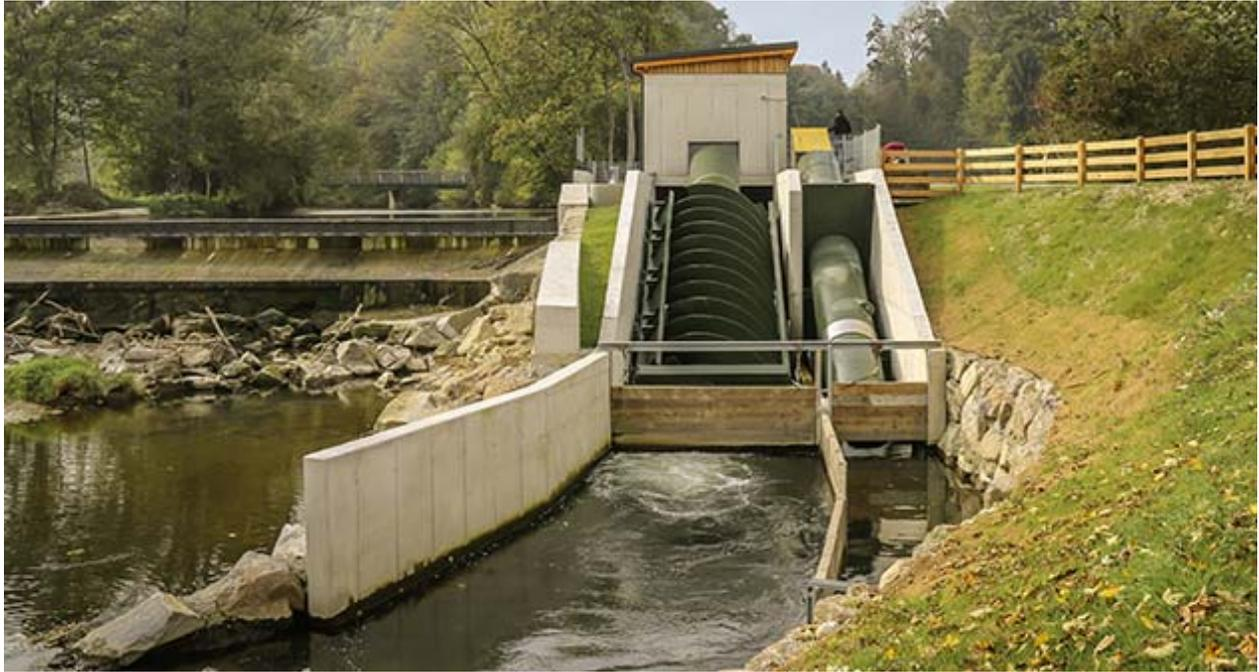
Abbildung 3: Kombination aus Wasserkraftschnecke (links) und FAS (rechts) an der Url, KW Pilsing (System Rehart/Strasser). Foto: <http://www.rehart-power.de>
