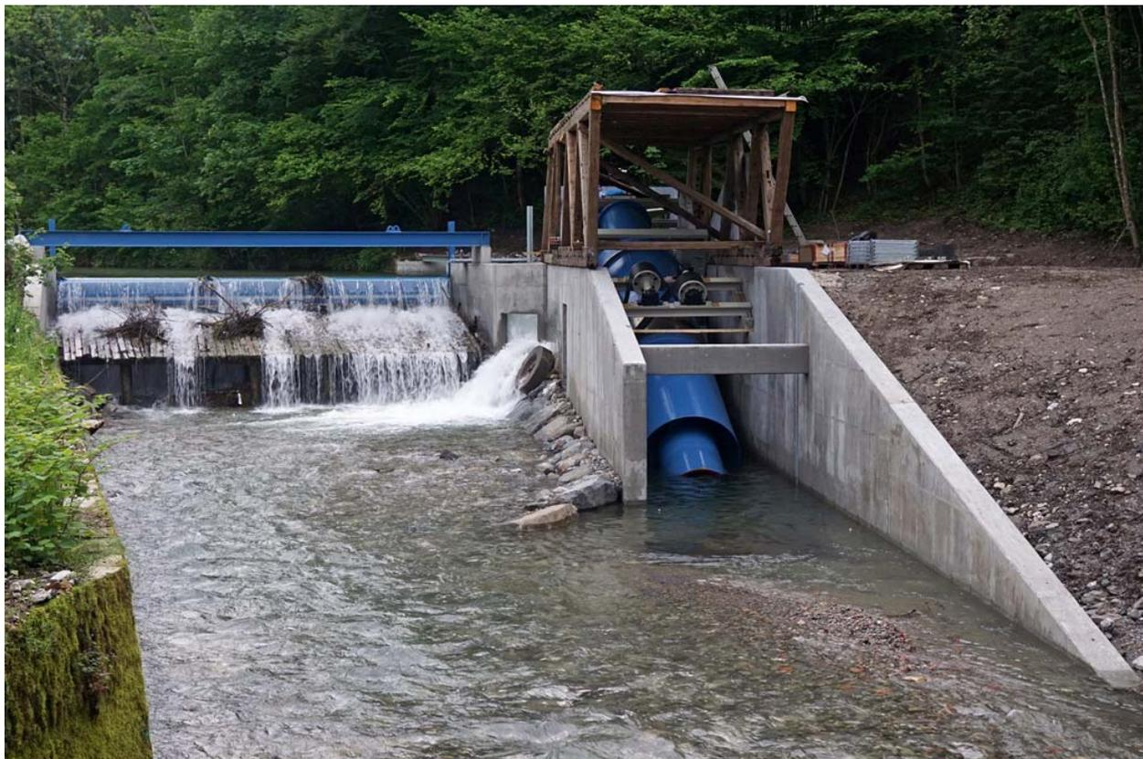
**Abbildung 6: FAS vom Typ Hydro-Connect am Beispiel der Anlage an der Jessnitz (in Bau).
