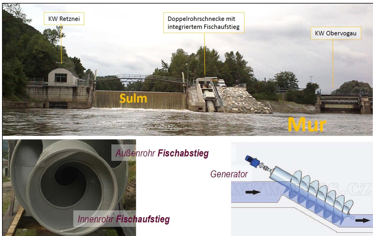
Abbildung 5: FAS vom Typ Hydro-Connect am Beispiel der Anlage an der Sulmmündung. Folie: PINTER (2017).
