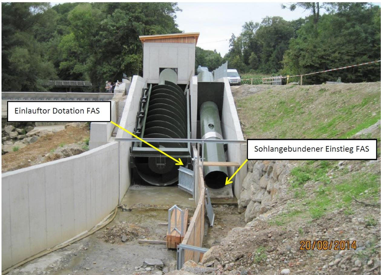
Abbildung 4: Dieselbe Anlage wie Abbildung 3 im trockenen Zustand. Foto aus: MITTERLEHNER, 2015.
