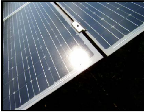
Abb. 6.2.3.1-1: Reflexion des Sonnenlichtes in 1 m Entfernung (Quelle: eigene Aufnahme, Espenhain 28.04.2005)
