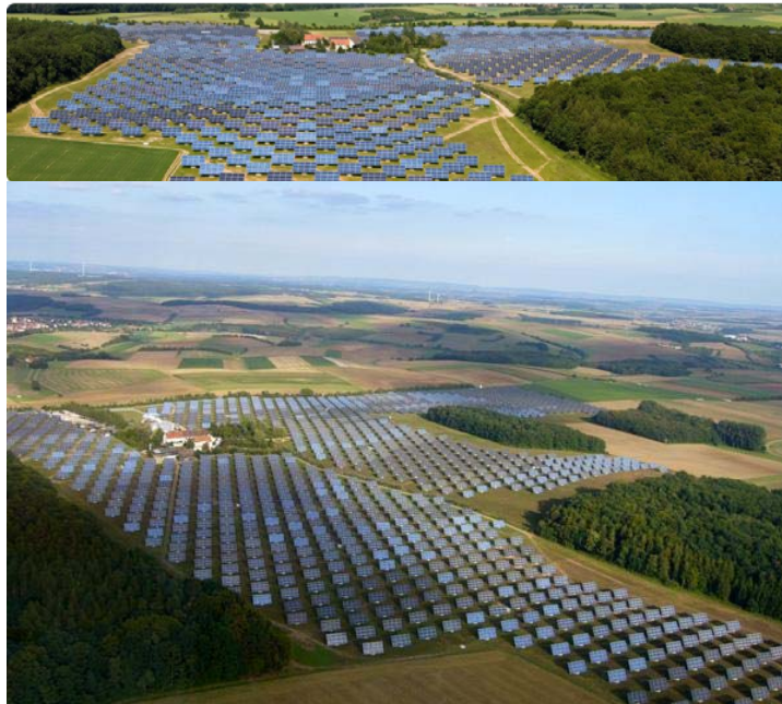
Abbildung 15: Solarpark Gut Erlasee, Deutschland, 12 MWp, Investitionsvolumen zirka 70 Mio. EUR, Fläche 77 Hektar, 1.408 SOLON-Mover, jährliche Stromproduktion 14.000 MWh, jährliche CO 2 -Ersparnis zirka 7.700 Tonnen, Solarstrom für rund 3.500 Haushalte 25
