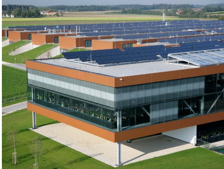
Abbildung 6: Photovoltaik-Anlage Fronius Standort Sattledt, OÖ, Anlagengröße 615 kWp, Inbetriebnahme 2007, Jahresproduktion 680 MWh, Module 2700 Sanyo HIP 215, Modulfläche 3.823 m 2 18
