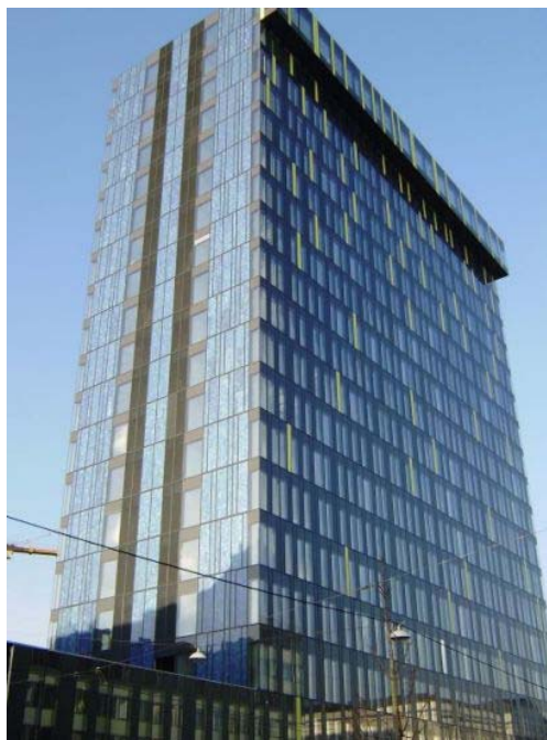
Abbildung 7: Power Tower Energie AG in Linz, Energieeffizientes Bürohochhaus mit 700m 2 fassadenintegrierter PV-Anlage an der Südwestseite, Module: 252 polykristalline VSG-Module (1.090 x 3.710 mm), Installierte Fläche: 638 m 2 , Installierte Leistung: 66 kWp, Energieertrag: ca. 42.000 kWh/a 19
