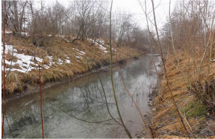
Abbildung 47: Qualmwassergang Stauraum Pucking
