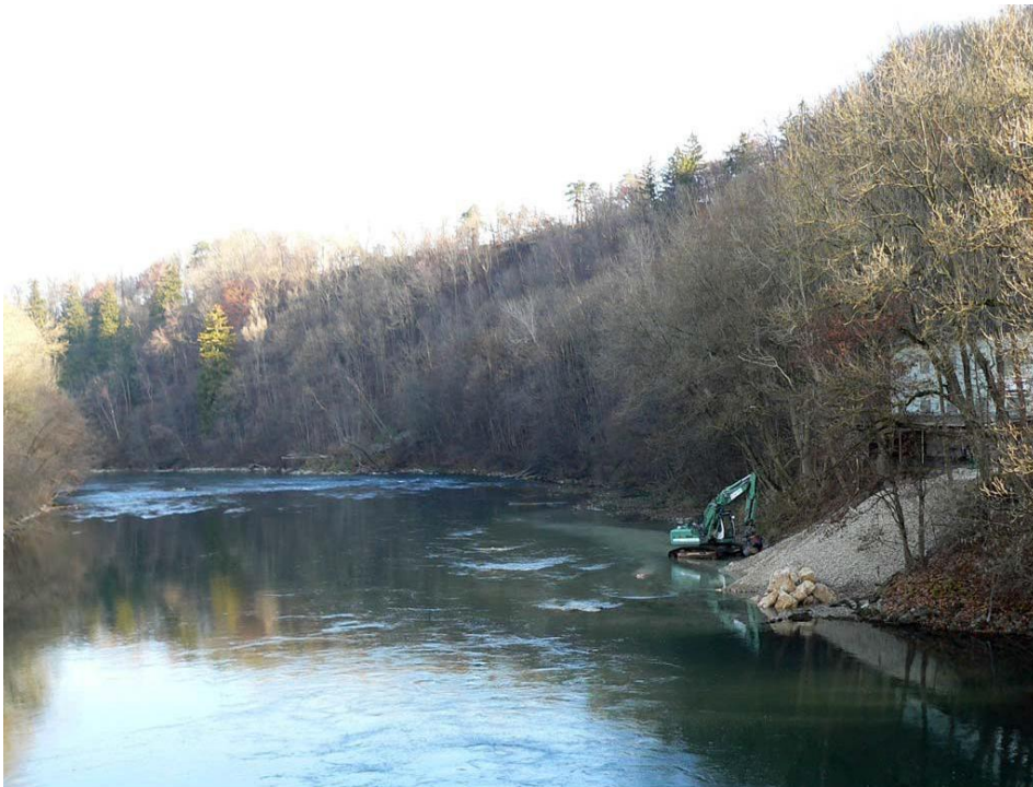
Abbildung 54: Herstellung eines Kieslaichplatzes am Lech. Foto: J. SCHNELL.
