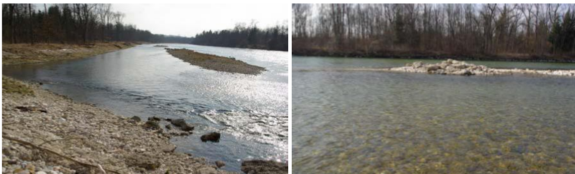
Abbildung 94: Aufweitung und Inselfschüttung stromauf des Gleithanges; durch Flussbausteine gesicherte Inselkopf
