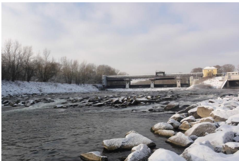
Abbildung 65: Unterwasser Traunwehr/ KW Kleinmünchen - Restwasserstrecke
