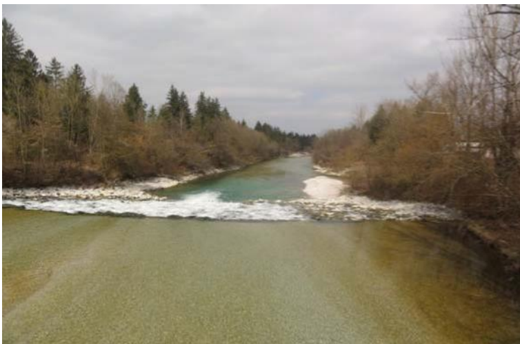
Abbildung 96: Nicht organismenpassierbares Rampenbauwerk bei fkm 0,9
