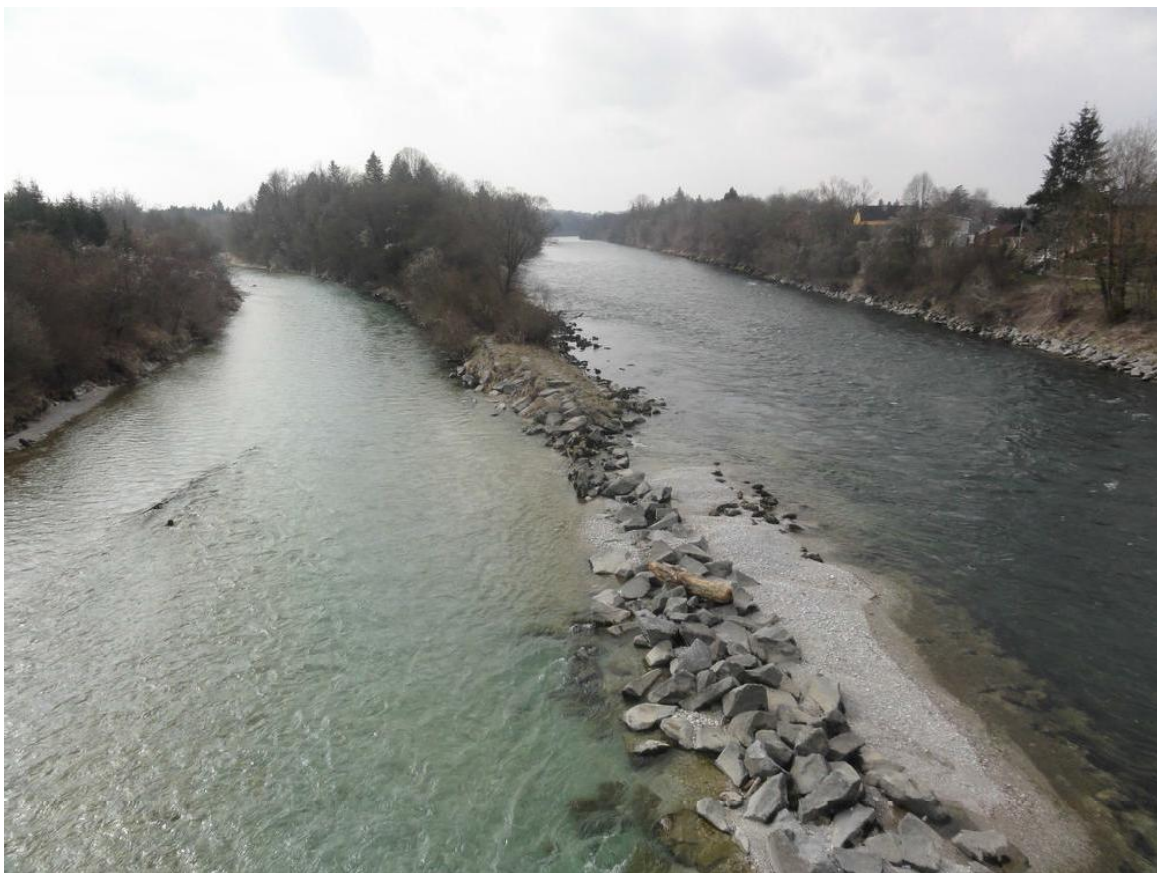
Abbildung 95:A Almspitz Blick stromauf; durch Blocksteine gebildetes Leitwerk und gesicherter Uferbereich mit bereichsweise vorgelagerten Kiesflächen
