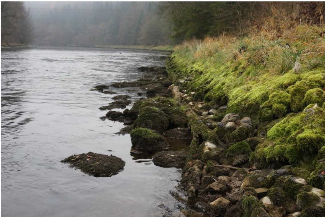
Abbildung 103: Lokale Ufersicherung der Traun im Bereich der ersten Kiesgrube
