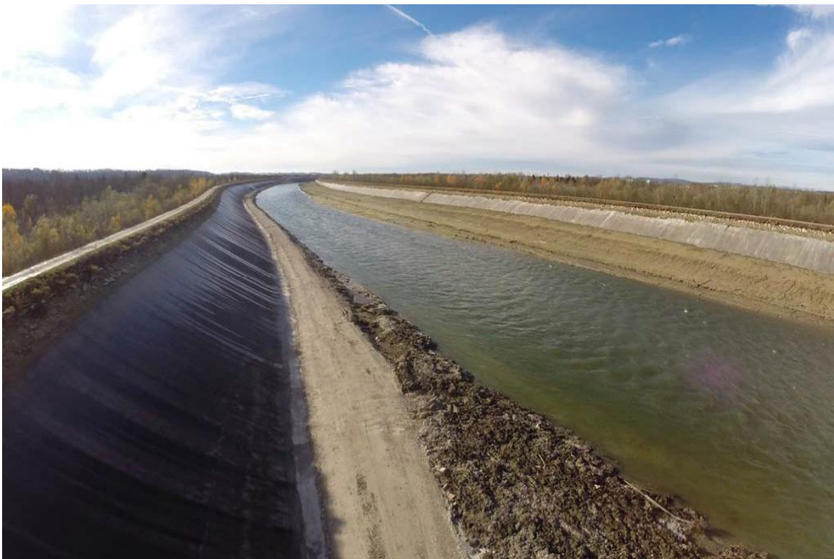
Abbildung 28: Staubereich KW Pucking während der baubedingten Staulegung (Aufnahme 10.11.2013).
