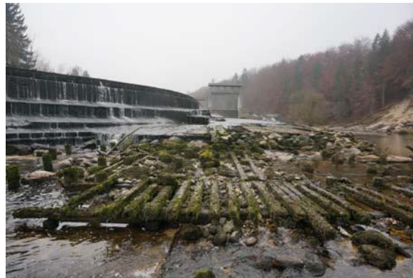
Abbildung 23: Das linke Bild zeigt die Reste eines Leitwerks unterhalb von Roitham; das rechte Bild zeigt Überreste einer Floßgasse beim KW Kemating
