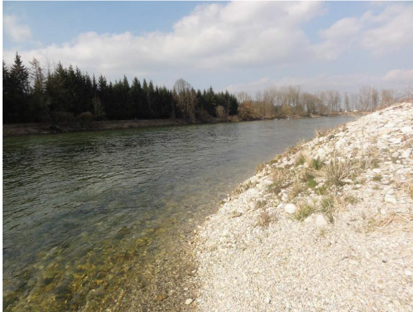
Abbildung 93: Im Zuge des Hochwasserschutzprojektes umgesetzte Kiesbank; deutlich erkennbar der aktuell noch sehr steile Gradient.
