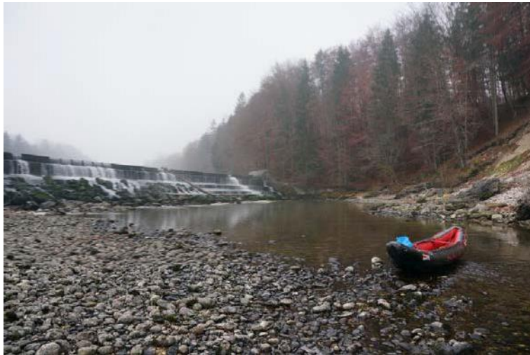
Abbildung 53: Stark vergrößertes Substrat unterhalb des Kematinger Wehres
