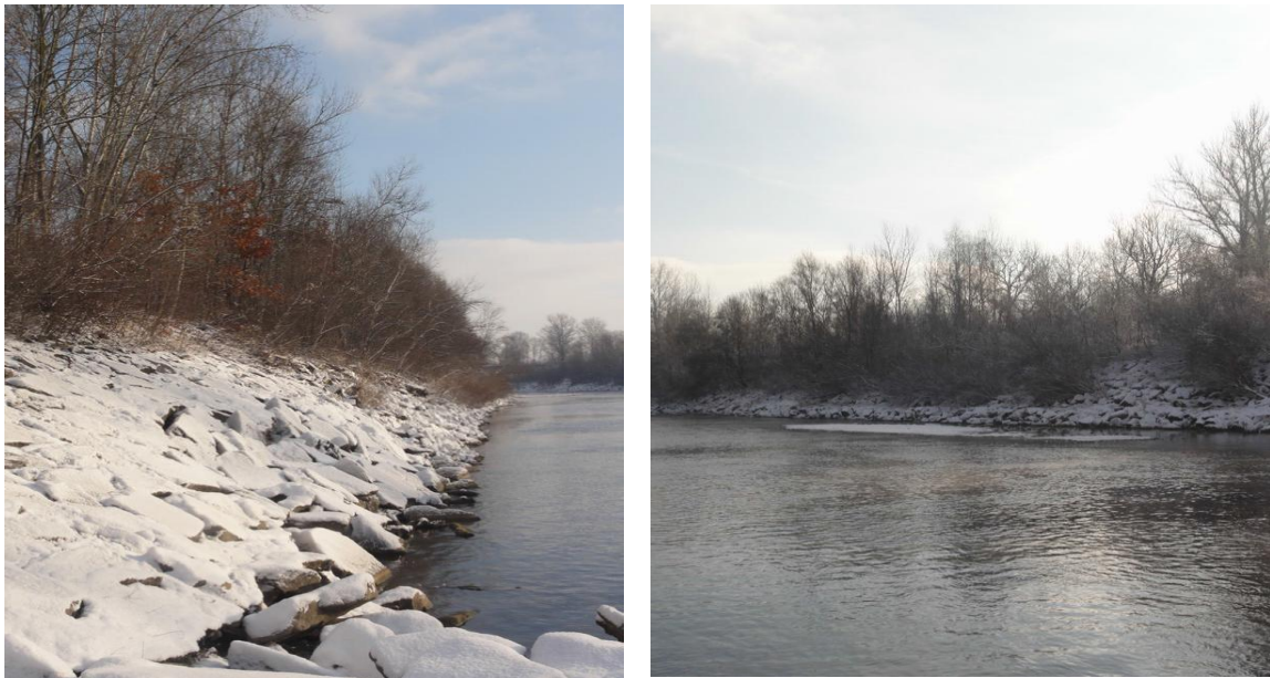
Abbildung 64: Durch Blockwurf gesichertes linkes Ufer im Unterwasserbereich des Traunwehrs - vorgelagerte Kiesbank an der linken Uferseite der Traun
