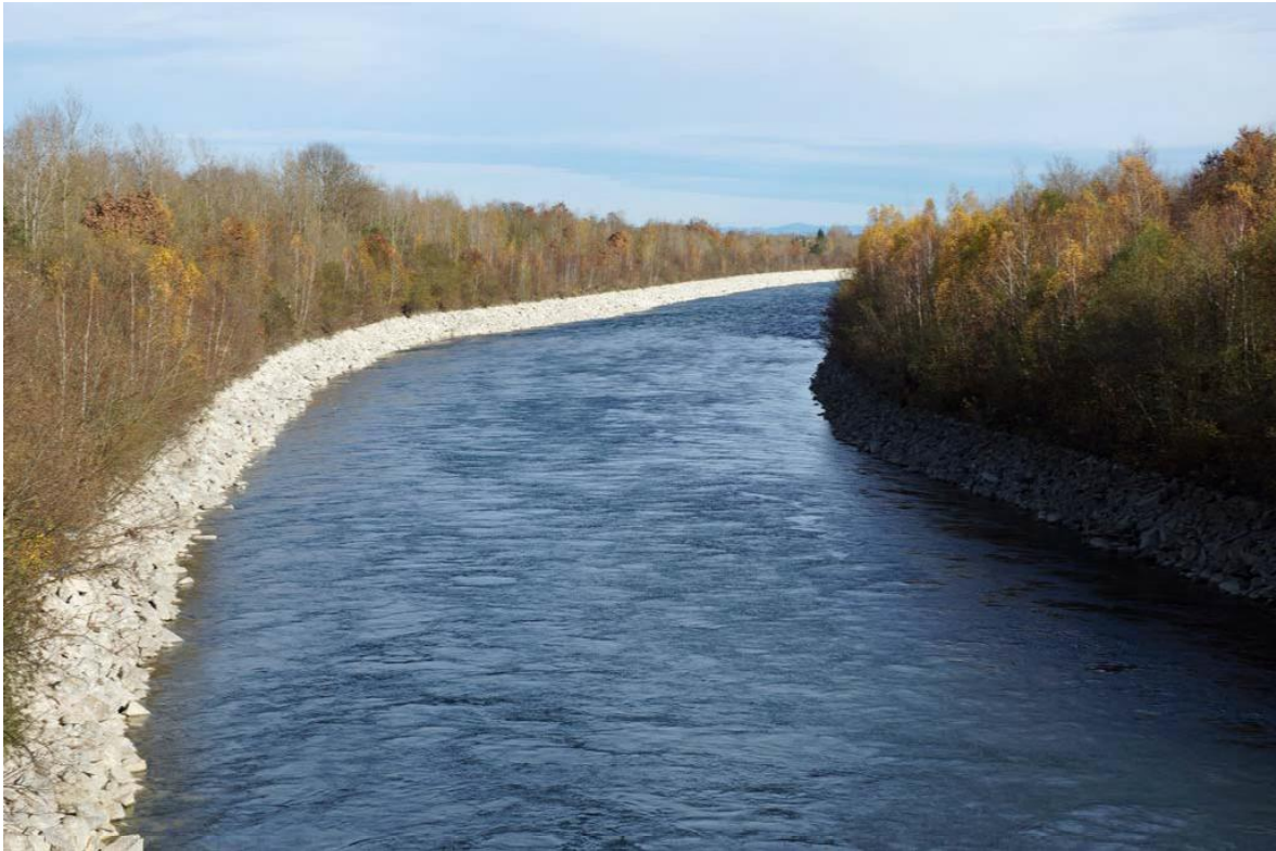
Abbildung 27: Stauwurzel KW Pucking während der baubedingten Staulegung (Aufnahme 10.11.2013). Durch die Absenkung sind die strukturarmen Uferzonen gut erkennbar.
