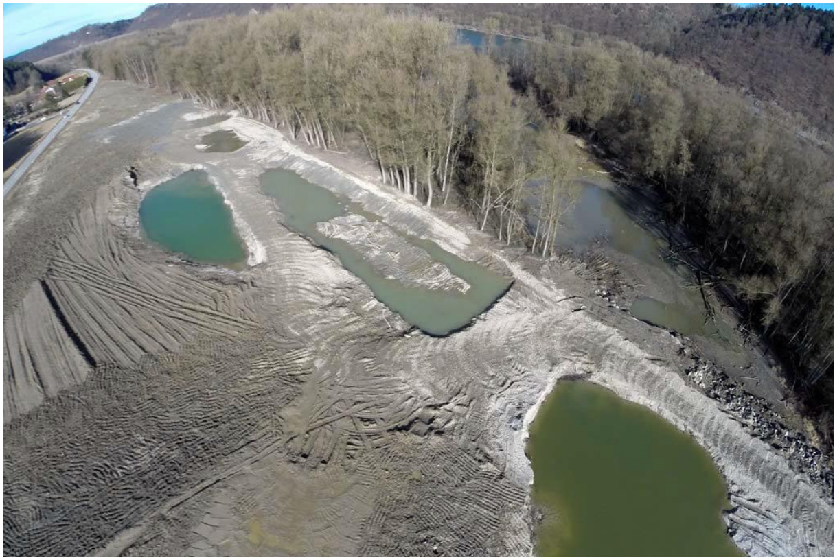
Abbildung 51: Schaffung eines Altarm-Kleingewässerkomplexes an der Donau in der Schildorfer Au im Bereich eines ehemaligen Fichtenforstes in der Bauphase (Winter 2013/14).
