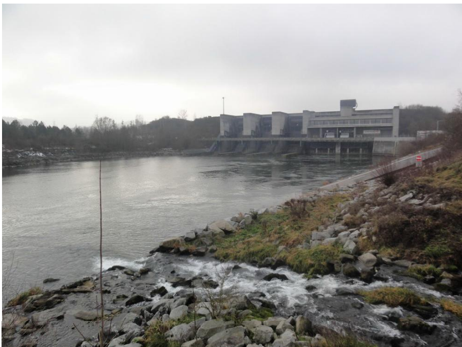
Abbildung 82: Unterwasser des Kraftwerks Marchtrenk mit Mündung des Sickergrabens im Vordergrund
