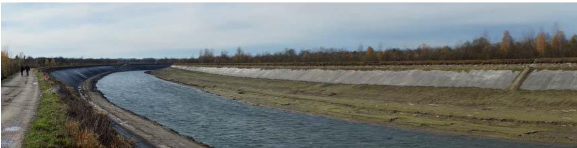
Abbildung 76: Traun im Stauraum Pucking im abgesenkten Zustand
