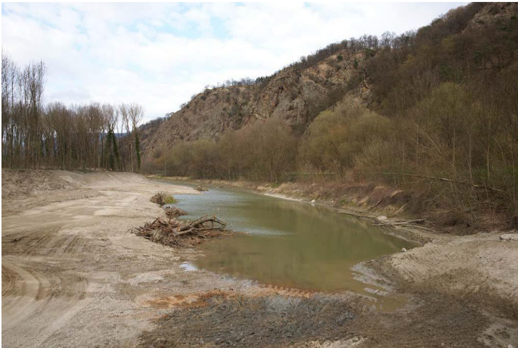
Abbildung 50: Nachträgliche Uferabflachung in einem einseitig angebundenen Altarm an der Donau bei Aggsbach in der Wachau (UFG-Projekt; Foto bei Niederwasser).
