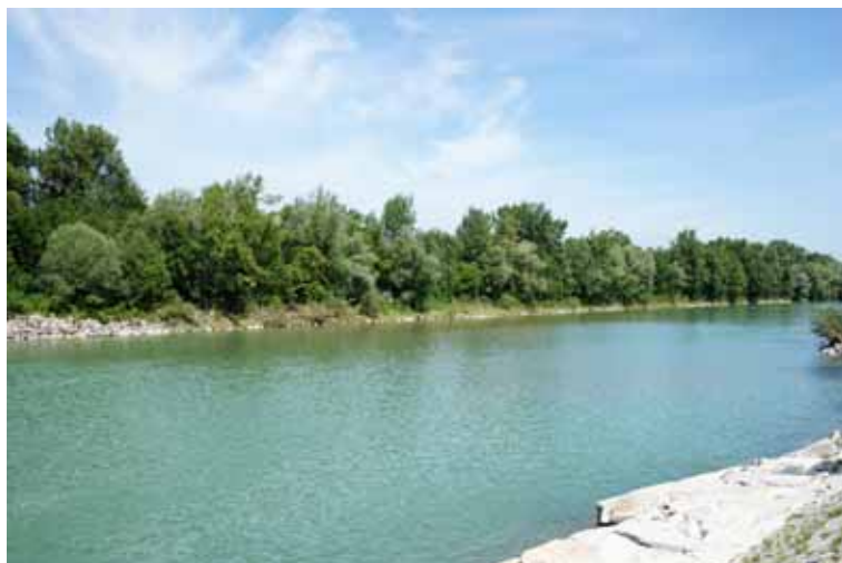
Abbildung 167: Blick ins rückgestaute Unterwasser des Hilfswehrs.
