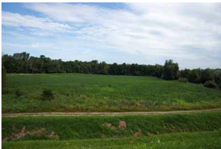
Abbildung 149: Blick von der Staudammkrone über den Acker.
