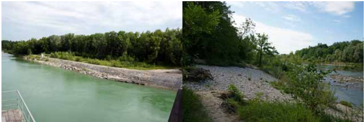
Abbildung 150: Links: Blick aufs rechtsufrige Vorland; Rechts: Hoch anstehender Schotter am rechten Ufer.
