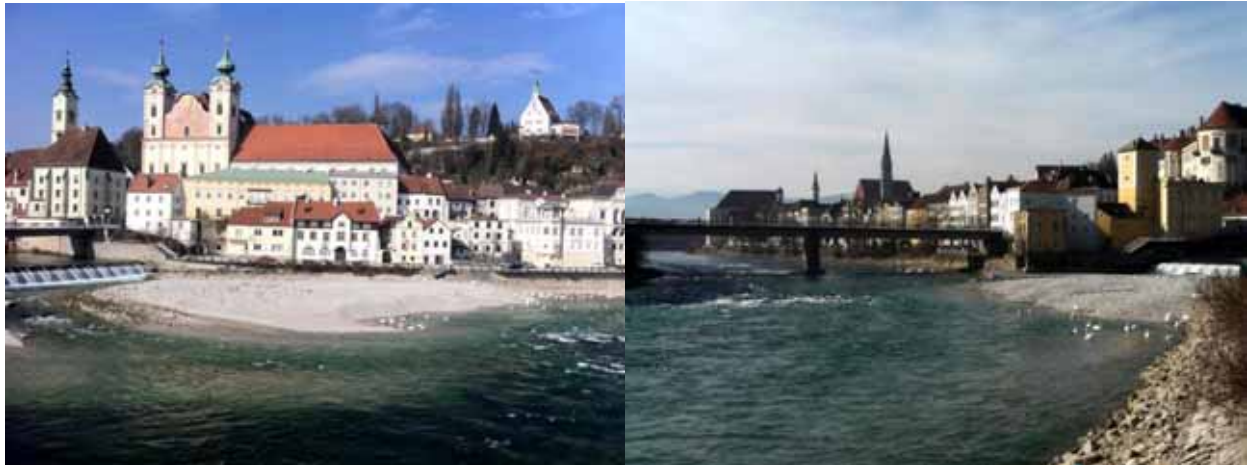
Abbildung 77: Blicke auf die Steyr-Mündung bei Niederwasser nach Umsetzung des Hochwasserschutzprojektes.
