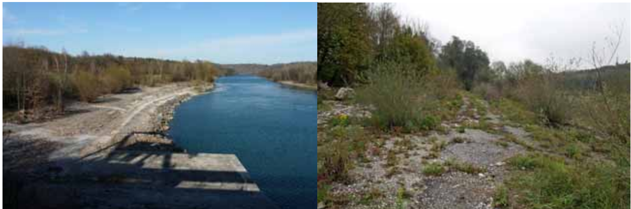
Abbildung 100: Links: Blick vom Kraftwerk Staning stromab. oberes Ende des Maßnahmenbereiches; Rechts: Asphaltierte Fläche im oberen Bereich der Maßnahme.
