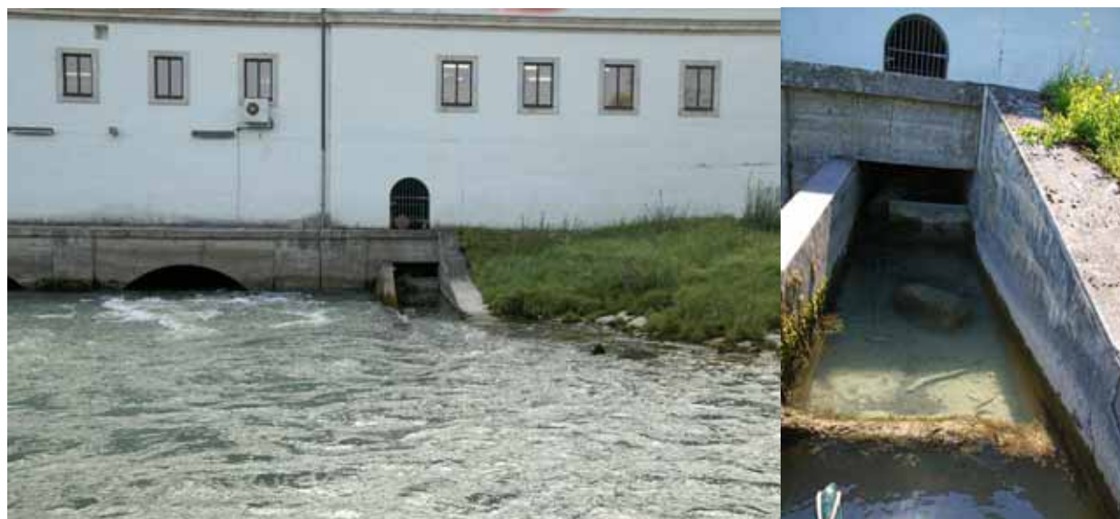
Abbildung 115: Blick auf den Einstieg in den bestehenden, alten Beckenpass (außer Betrieb).
