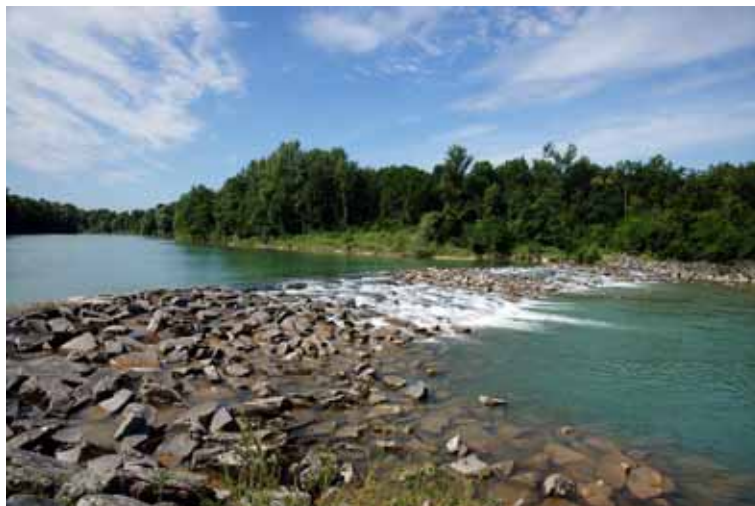
Abbildung 152: Blick stromaufwärts auf die obere Rampe.
