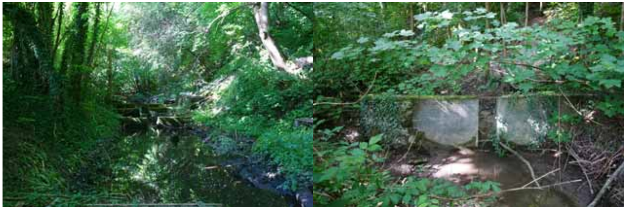
Abbildung 147: Einbauten im Lahnbach auf Höhe der Ackerfläche (links) und nahe der Mündung in die Enns (rechts)
