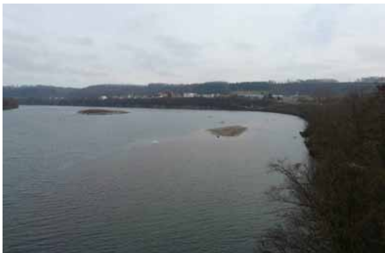
Abbildung 89: Blick von der Nordspangenbrücke flussabwärts – in der Außenbiegung befindet sich ein sehr seichter Bereich, der schon bei geringer Absenkung teilweise trocken fällt (rechte „Insel“, bei Vollstau überstaut).
