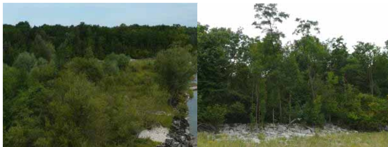
Abbildung 144: Linkes Ufer unterhalb des KW Thaling: Der Blockwurf am Ufer (links) soll entfernt werden, ebenso die Sicherung der etwa 100 m dahinter gelegenen Böschung (rechts).
