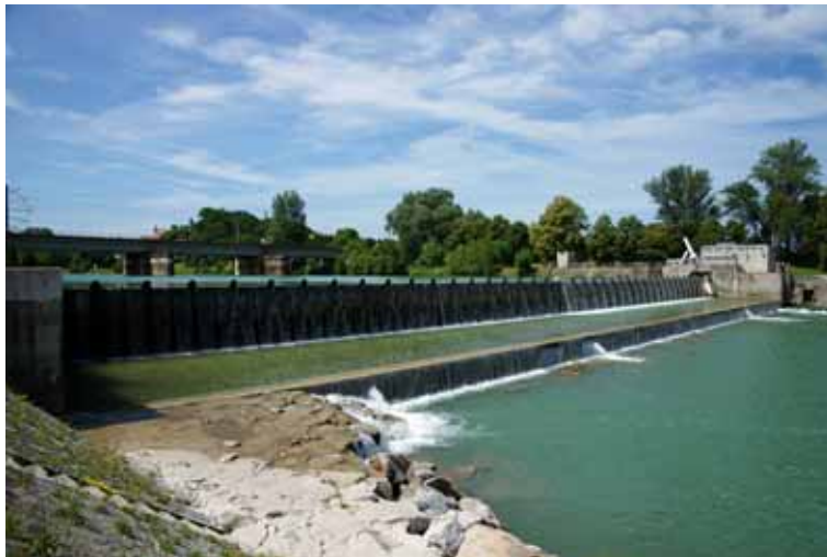
Abbildung 164: Blick auf den Einstiegsbereich.
