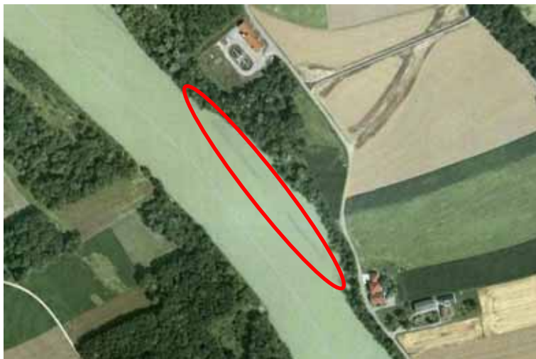
Abbildung 127: Lage des überstauten Leitwerks.
