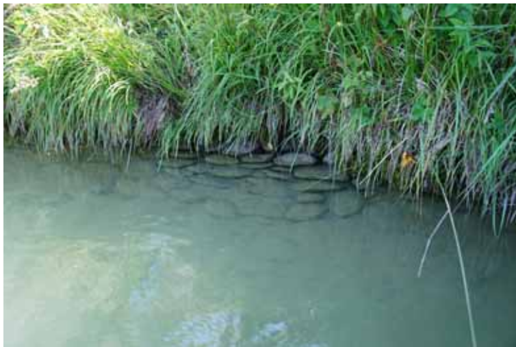
Abbildung 119: Altes Uferdeckwerk im Maßnahmenbereich.
