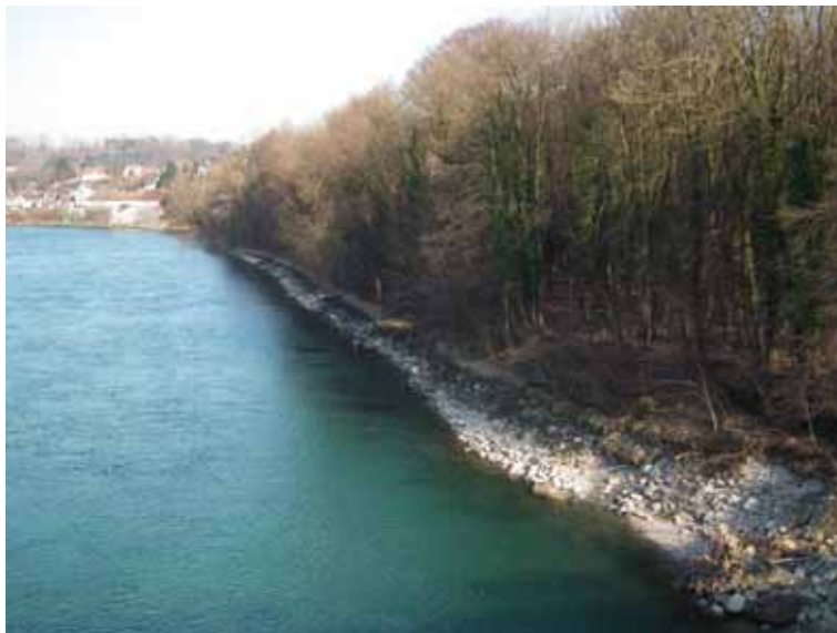
Abbildung 81: Blick von der Brücke auf das Außenufer der Rederinsel nach Umsetzung des HWSchutzPj.
