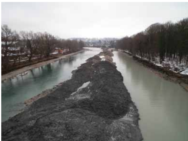
Abbildung 67: Blick stromab der Rederinsel; Baumaßnahmen im Jänner 2011.
