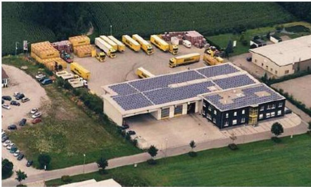
Abbildung 5.2.2-1: Transportunternehmen Hammerer, Kärnten, Weißwasser für die Reinigung der LKW-Transportcontainer (Leistung: 126 kW th ; Kollektorfläche: 180 m 2 ). 6
