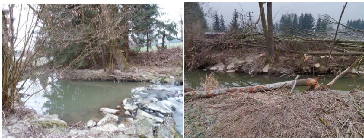
Abbildung 30: Kleines Steinwehr am Altbach nördlich der L1095 (links); Schlägerungsarbeiten im Bereich des Ufergehölzes südlich der L1095 (rechts).
