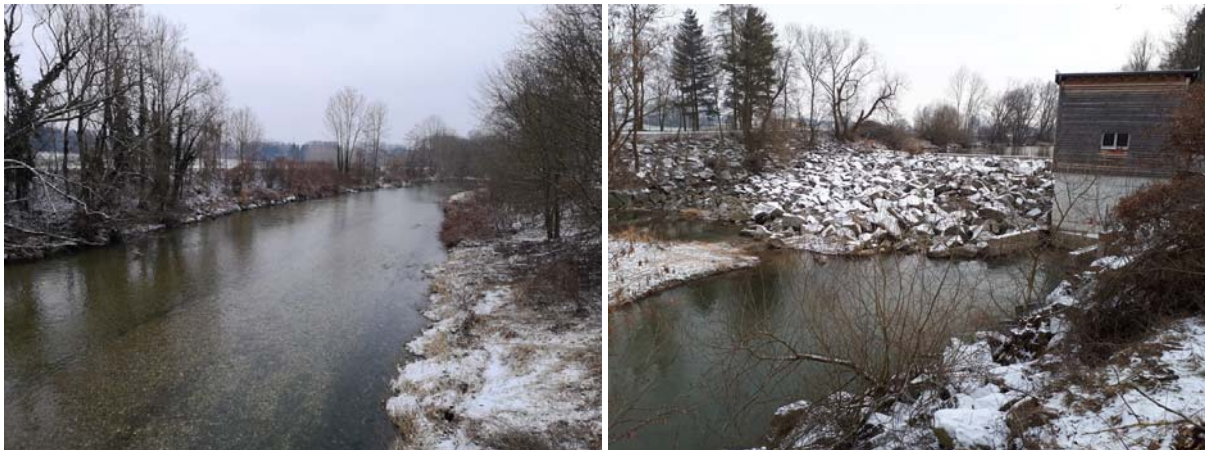
Abbildung 5: Blick von der Brücke der L1100 westlich von Mühlheim flussauf (links); Wehranlage 1 (rechts).
