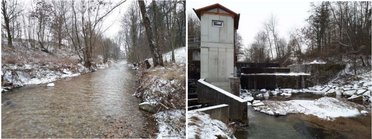
Abbildung 19: Der Lochbach bei Gunderding (links); Wehranlage am Lochbach zw. Gunderding und B148 (rechts).
