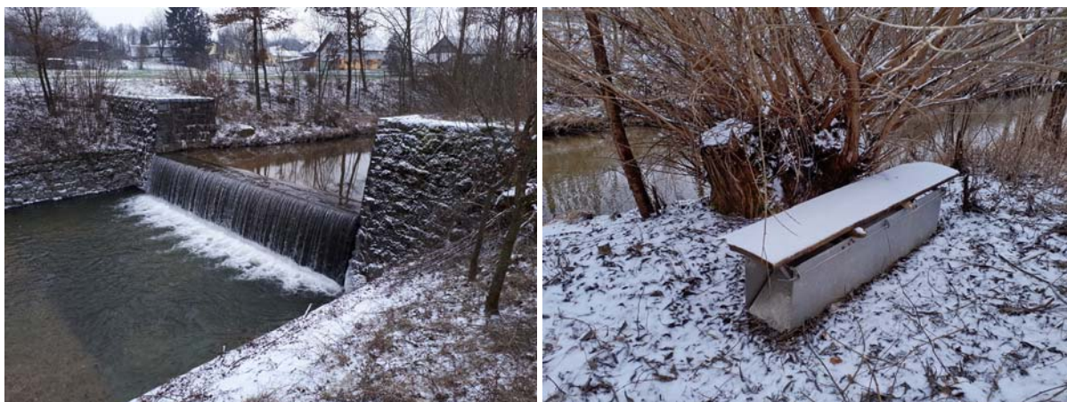
Abbildung 18: Sohlschwelle im Lochbach bei Gunderding (links); Lebendfalle oberhalb der Sohlschwelle neben frischer Biberfällung (rechts).
