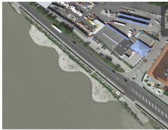
Vorlandschüttungen Mauthauen (stromaufwärts der Brücke)
