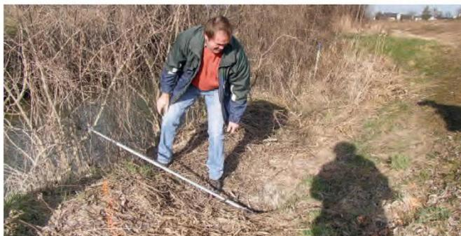
**Abb. 7.1.** Biberröhreneingang in der Steinschichtung eines Werkskanals (o., © G. Hölzler.); Biberröhren in der Berme, also dem horizontalen Stück in der Böschung des Machlanddamms (u., © Amt der Oö. Landesregierung, Abt. Naturschutz, B. Schön).
