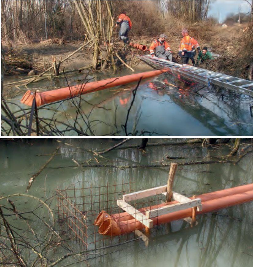
Abb. 8.9. Biberdamm-Drainage in Nettingsdorf: Bauphase (o.), Drahtgitterkorb am Rohreinlass (© Amt der Oö. Landesregierung, Abt. Naturschutz B. Schön).
