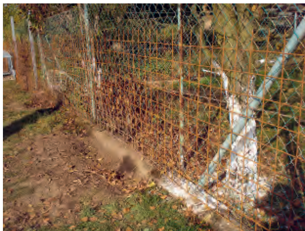
Abb. 6.16. Additivzaun, an bestehendem Zaun angebracht, mit kleiner Mauer (© G. Hölzler).
