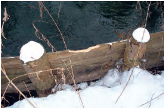
Abb. 6.3. Benagungen durch den Biber: Stauraumverplankung (li.); Ränder eines Holzschützes bei einem Kleinkraftwerk (© G. Hölzler).
