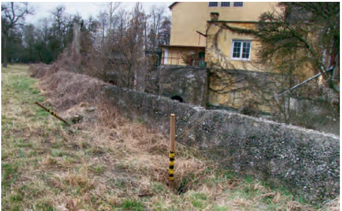
Abb. 5.12. Vom Biber hintergrabene Ufermauer mit 2 Röhreneinbrüchen unterhalb einer Mühle in Schönering, gekennzeichnet durch schwarz-gelb geringelte Pfähle (© Amt der Oö. Landesregierung, Abt. Naturschutz, B. Schön).
