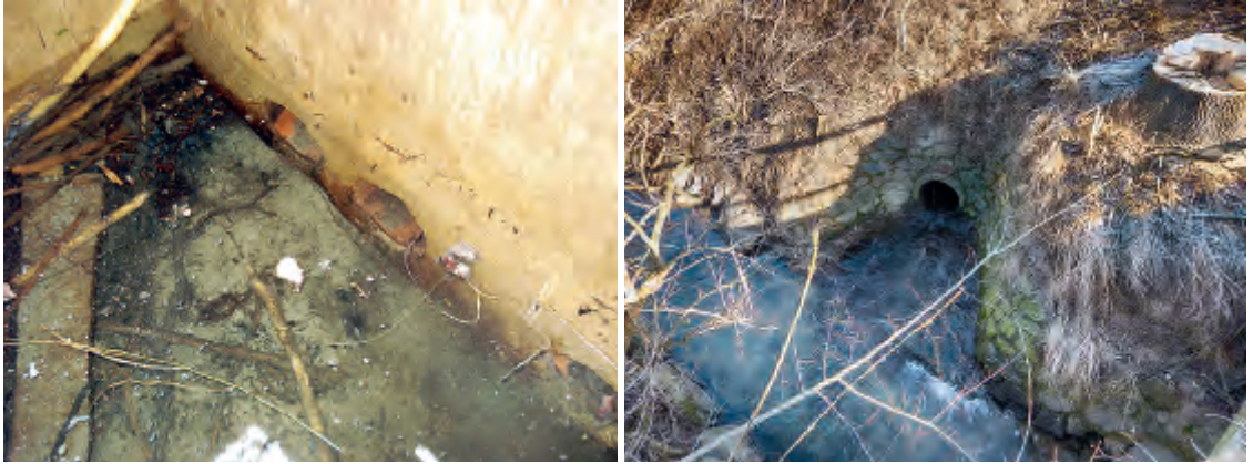
Abb. 8.4. Durch den Biber eingestauter Schacht: Anstatt zu entwässern, wird die Feld-Drainage zur „Bewässerungsanlage“ (li.); Ausleitung einer Kläranlage, die durch einen Biberdamm nahezu lahmgelegt wurde (re., © G. Hölzler).
