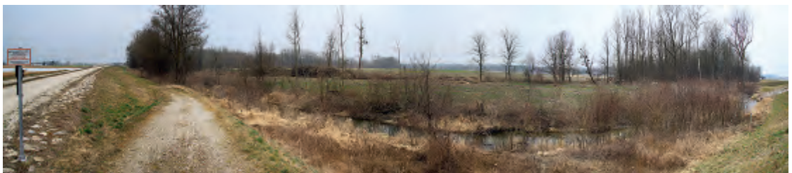
Abb. 5.8. Panoramabild Hochwasserschutzdamm Machland ( © Amt der Oö. Landesregierung, Abt. Naturschutz, B. Schön).
