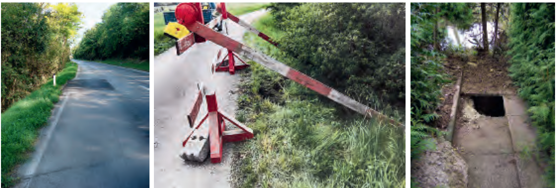
Abb. 7.3. Eine stark befahrene Landstraße wurde vom Biber untergraben (li.); eingebrochener und gesicherter Fahrradweg unmittelbar neben dem Gewässer (m.); untergrabener Gartenweg (re., © G. Hölzler).
