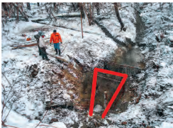
Abb. 8.12. Bibertäuscher: Grundriss (li.), Anwendung bei ehemaligem Fischteich (halbfertig, rote Linien, re., © G. Hölzler).
