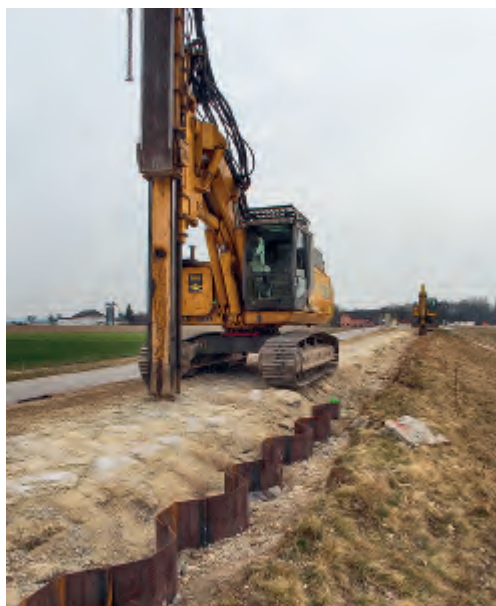
Abb. 7.10. Machlanddamm mit 400 m Spundung (o.), Maschine dazu (u., © G. Hölzler).
