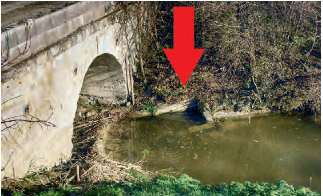
Abb. 8.14. Einmündung eines Hauptsammlers einer Felddrainage (roter Pfeil) in den ableitenden Bach (Vorfluter): Just im Bereich einer Feldwegbrücke hat der Biber einen Damm errichtet, der die Drainagewässer mitnutzt. Die Dammentfernung ist nur händisch und äußerst schwierig zu bewerkstelligen (© G. Hölzler).
