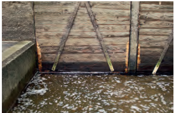
Abb. 6.3. Benagungen durch den Biber: Stauraumverplankung (li.); Ränder eines Holzschützes bei einem Kleinkraftwerk (© G. Hölzler).
