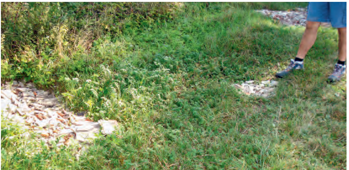
Abb. 7.6. Mit Schotter und Ziegelbruch reparierter Bereich eines Feldweges (re., © G. Hölzler).
