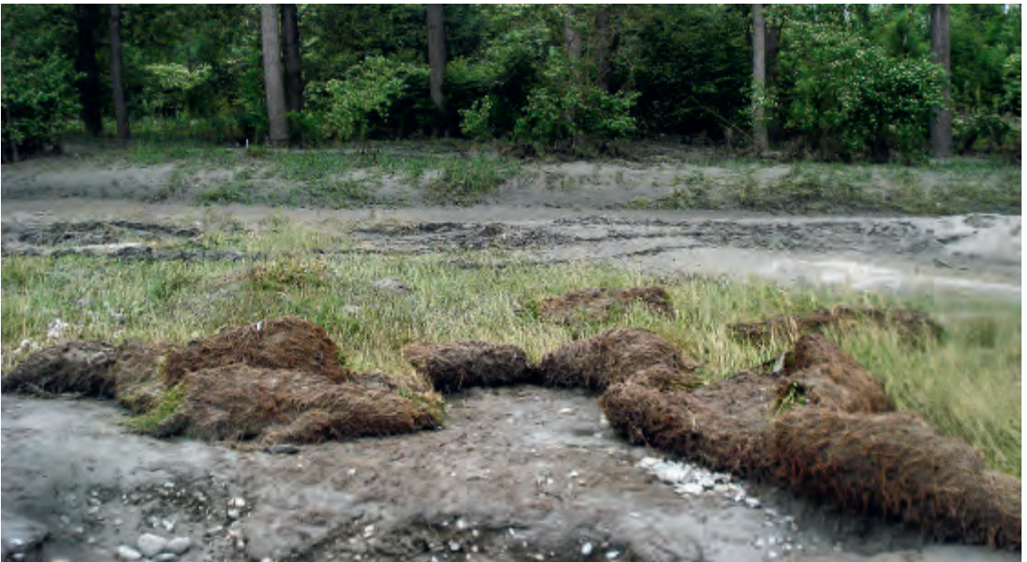
Abb. 3.13. Spuren des Donauhochwassers 2013 im Bereich einer Überströmstrecke: Wassermassen transportieren viel Holz mit sich (o., © F. Zeiser); deutlich sichtbar sind die durch die Kraft des Wassers abgeschälten Rasenbereiche und die Schlammablagerungen (u., © G. Hölzler).
