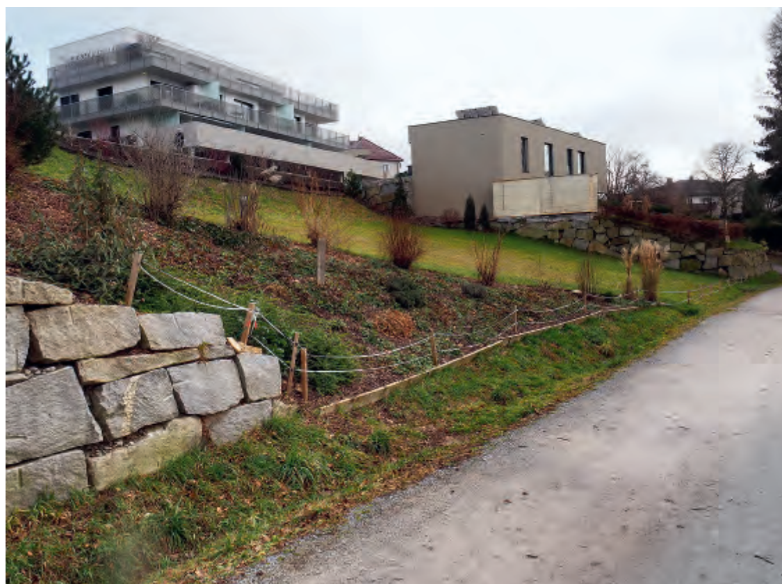
Abb. 6.17. Dieser E-Zaun zum Aussperren des Bibers zeigt eine zu schlafe und vom Boden aus zu hohe Litzenführung (© Amt der Oö. Landesregierung, Abt. Naturschutz, B. Schön).
