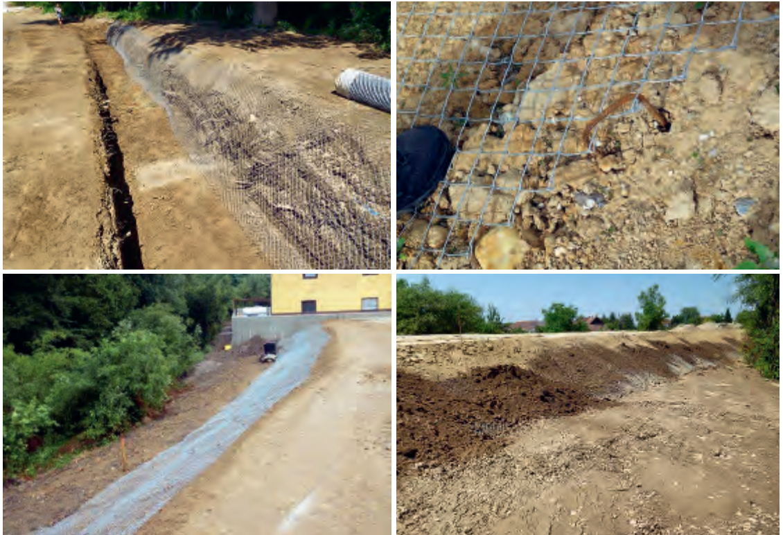
Abb. 7.7. HWS-Damm Neubau mit Biberschutzgitter in St. Pantaleon-Erla: in den Dammfuss wird wasserseitig das Schutzgitter eingebracht und verfüllt (li.o.), am fertigen Damm sieht man das Gitter wasserseitig (re.o.), das Schutzgitter wird mit umgebogenem Torstahl am Damm fixiert (li.u.), über das Gitter wird Humus aufgebracht (re.u., © F. Zeiser).
