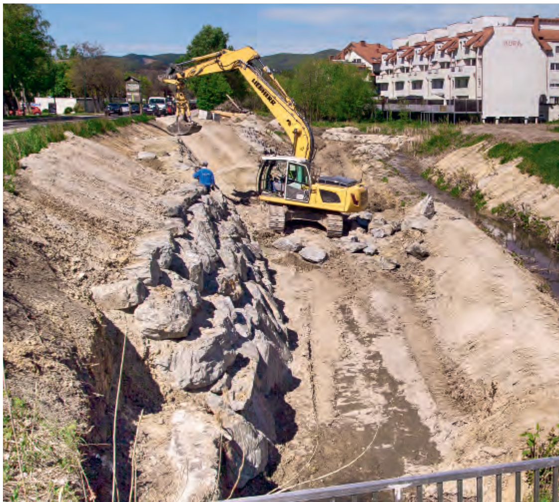
Abb. 7.9. Sicherung eines Gewässerufers zu stark befahrener Straße hin (© G. Hölzler).
