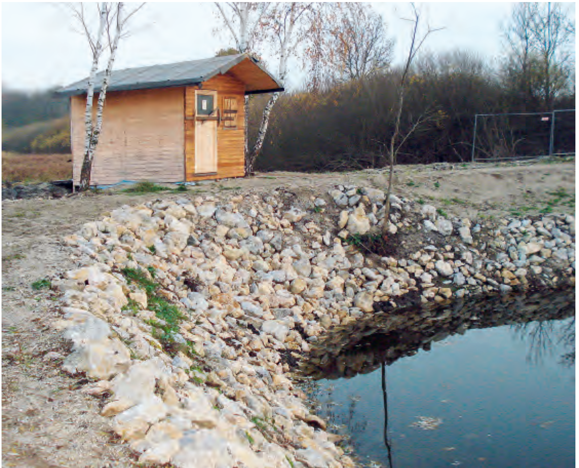
Abb. 7.8. Teichsanierung mit Steinschüttung (© G. Hölzler).
