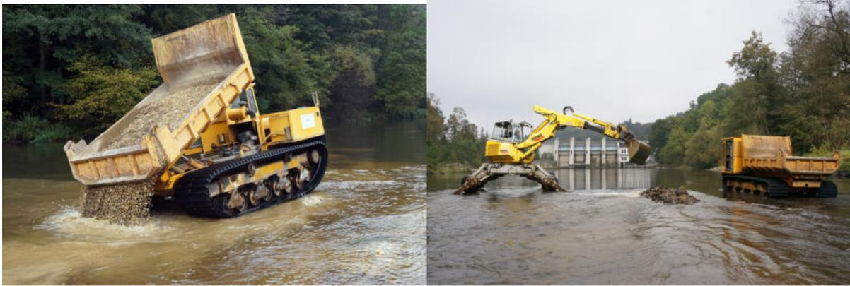
Abbildung 8: Einbau von Kieslaichplätzen durch Kieszugaben in der Ilz flussab des Staus Oberilzmühle.
