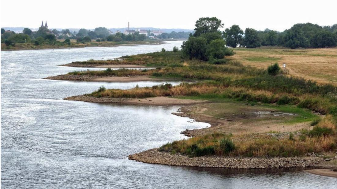
ABBILDUNG 12: UFERSTRUKTURIERUNG DURCH BUHNEN AN DER RUHR (EIGENE AUFNAHME, 2020).
